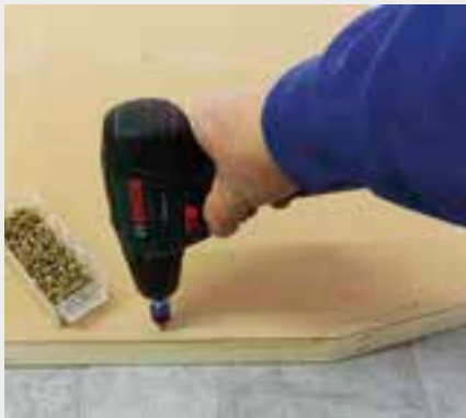
1. Bodenplatten anschrauben
